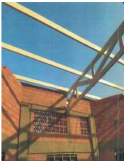
Foto 1. Y Foto 2. Cambio de cubierta
